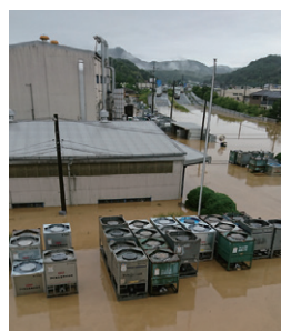
2018年 7月7日撮影 浸水の様子
