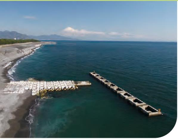
世界文化遺産“富士山”の構成資産である三保松原の砂浜を守るため、静岡市清水海岸の突堤に当社の特許工法であるS-VHS工法が採用されています。S-VHSは波浪の勢いを弱めるスリットが全体に配置された沖側が斜面形状のケーンソで、鋼管杭の基礎によって地盤にしっかりと固定されています。当社の技術が駿河湾の厳しい波浪を和らげて白砂青松の保全に寄与し、景観改善と地域防災の両面で貢献しています。
