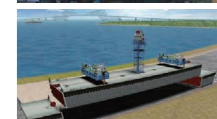
「キーエレメント工法」による沈埋函掘付
