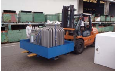
使用を中止したトランスの搬出風景 (絶縁油にPCBが使われている)
