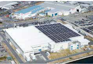
図 13 名古屋第一工場 750kW 発電設備
