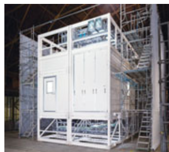
KaMoSを構成するモジュールは垂直方向3段のモジュール(シーリングモジュール、フロアモジュール、アンダーモジュール)に分割され、それらを水平方向に接続することで施設を構成
