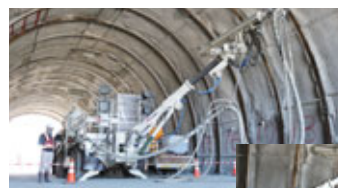
模擬トンネル内で行われた自動吹付けのデモンストレーションの様子
