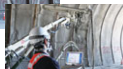
模擬トンネル内で行われた自動吹付けのデモンストレーションの様子
