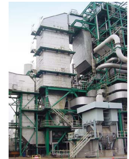
排煙脱硝装置
