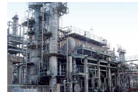
排煙脱硫装置
