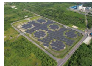
下松メガソーラー発電所
