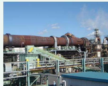
JX金属小牧ケミカル ロータリーキルン式焼却炉
