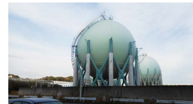
球形タンクのブレース(筋交い)補強
