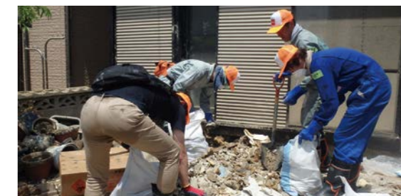
瓦礫撤去作業の様子
