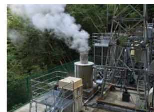
下田温泉バイナリー発電所
