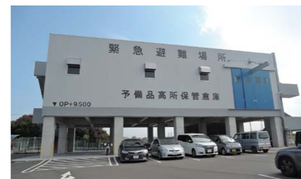
高所保管倉庫(堺製油所)
