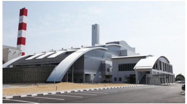
熊本市新西部環境工場
