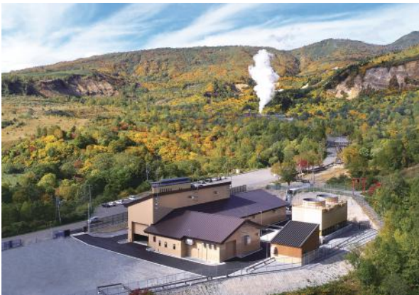
岩手地熱(株) 松尾八幡平地熱発電所
