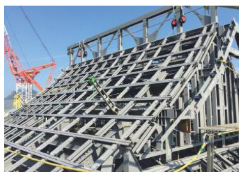
熊本城 大天守6階鉄骨造の外観
