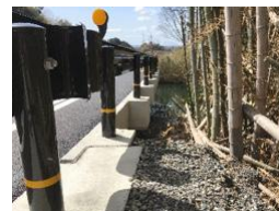
高炉水砕スラグ細骨材を用いたプレキャストブロック施工例
