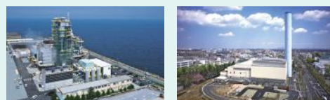
バイオマス発電プラント 廃棄物発電プラント
