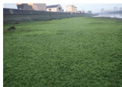
干潮時に海中から現れた広島県福山市内港のマリンストーン®敷設部。一面に海藻が生育している。
