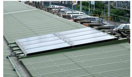
太陽光発電パネル(尾張瀬戸駅)
