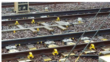
センサー設置状況
