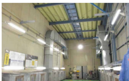
名鉄自動車整備場 整備用施設LED照明
