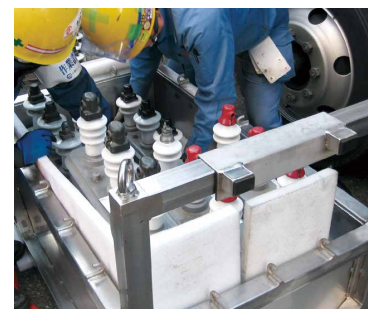
PCB廃棄物の搬出作業
