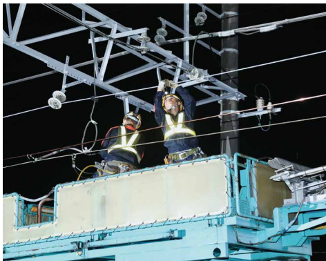
電気保守作業
