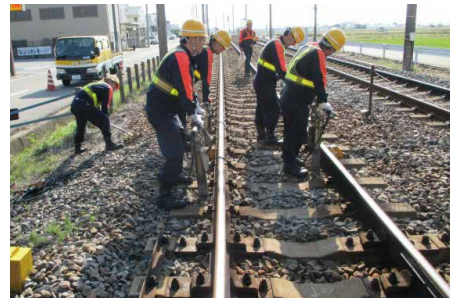
土木保守作業
