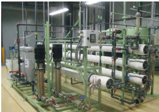
逆浸透膜を用いたろ過装置
