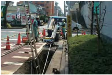
ガス管を埋設するための立坑
