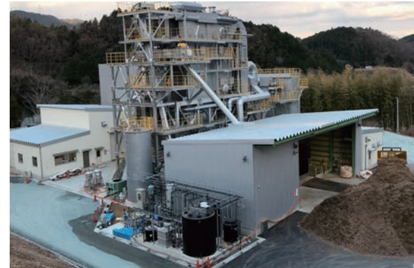
松阪バイオマス発電所
