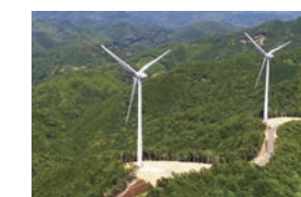
印南風力発電所
