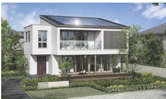
スマートハウス外観
