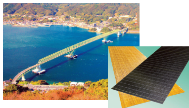
山口県の大島大橋(左)の補修工事に採用された炭素繊維複合材料(右)
