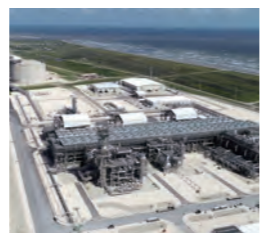
米国フリーポートLNG基地 Freeport LNG Development, L.P.提供
