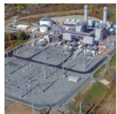
米国フェアビュー 天然ガス火力発電所
