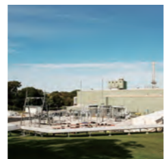
米国ミシガンパワー 天然ガス火力発電所
