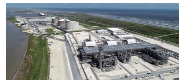
米国フリーポートLNG基地 Freeport LNG Development, L.P.提供
