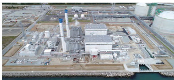
福島天然ガス発電所
