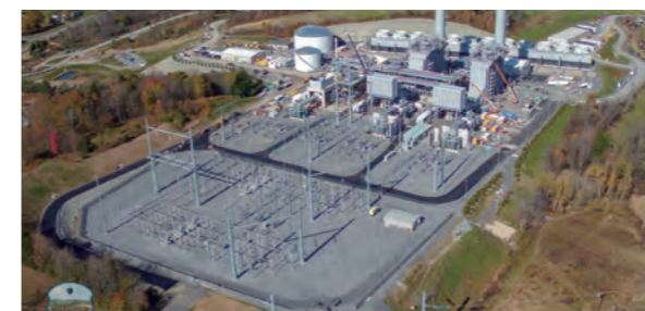
米国フェアビュー天然ガス火力発電所
