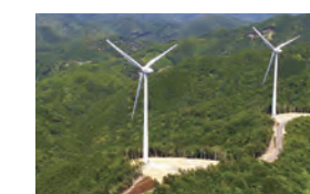
印南風力発電所
