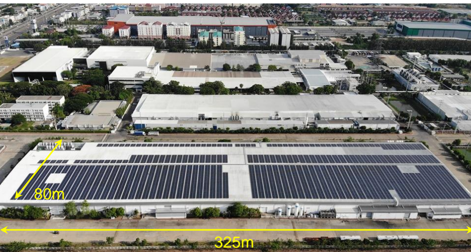
バンパイン工場
