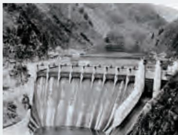
日本初のコンクリート高堰堤・大峯ダム(1924年、京都府)。1964年の天ヶ瀬ダム建設で水没
