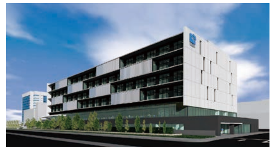
新事務・厚生棟
