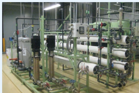
逆浸透膜を用いたろ過装置
