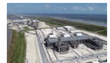
Freeport LNG Terminal in the United States Courtesy of Freeport LNG Development, L.P.
