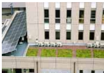
太陽電池パネルと屋上の植栽
