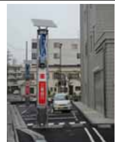
風力・太陽光発電を利用した照明灯
