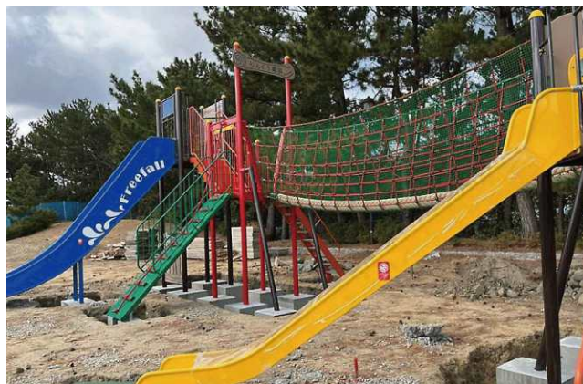
公園遊具改修工事
