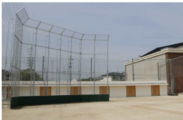
中学校屋外改修工事
