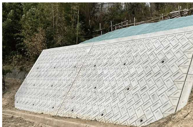
用水路災害復旧工事
