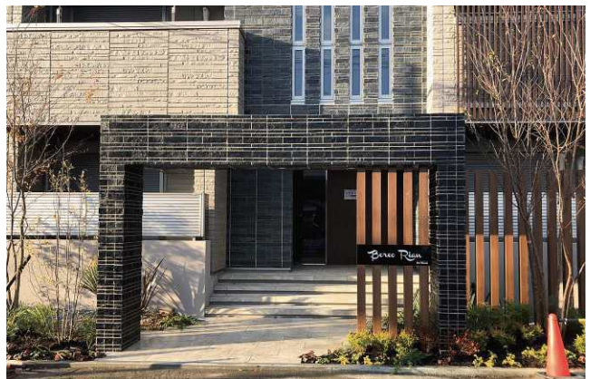
集合住宅外構工事
