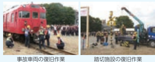
事故車両の復旧作業
